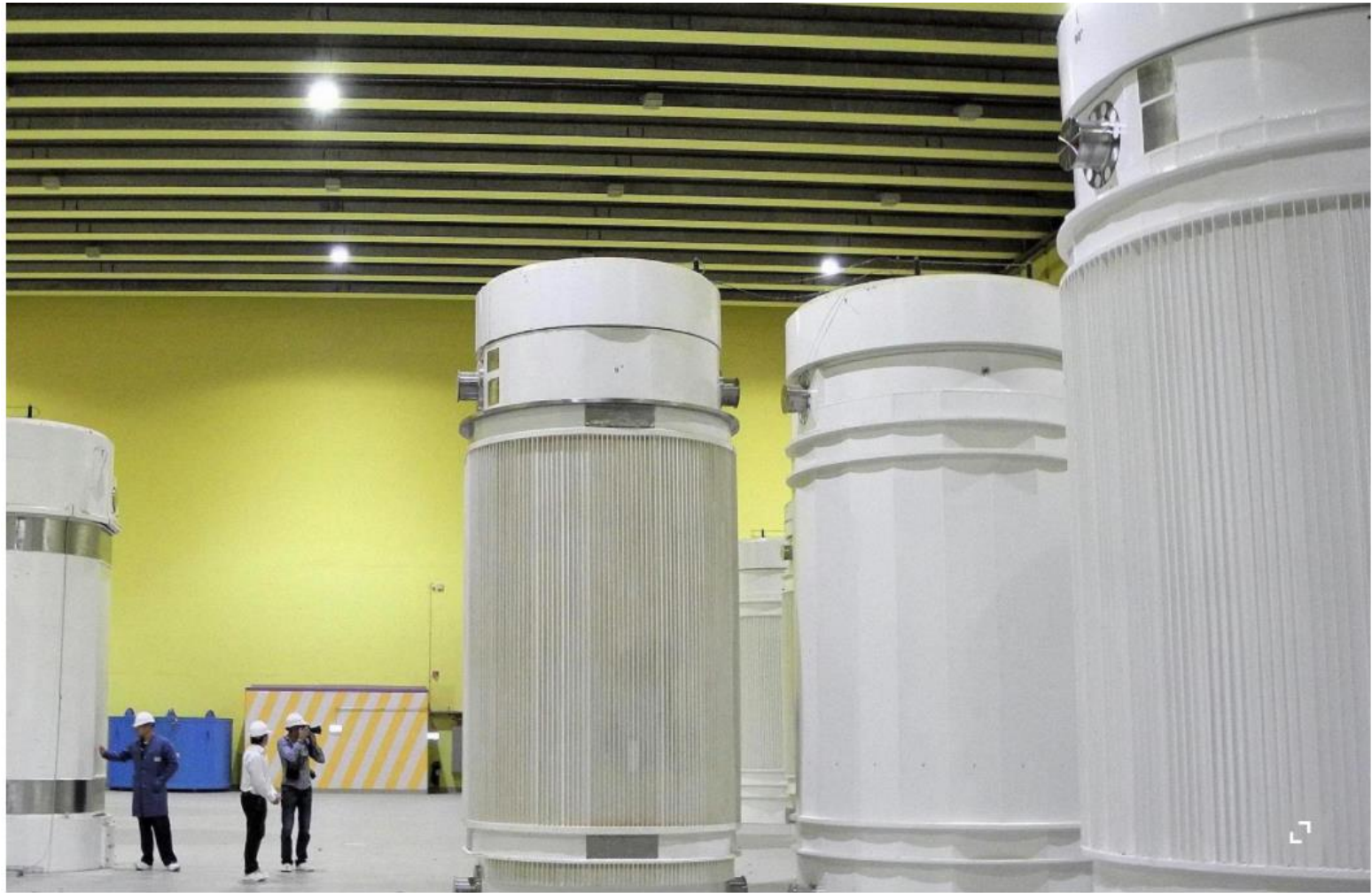
Verpackt in Lager- und Transportbehälter: Im zentralen Zwischenlager bei Würenlingen lagern die meisten hochradioaktiven Abfälle der Schweiz. Und zwar so lange, bis das geologische Tiefenlager als Endlager gebaut ist.
